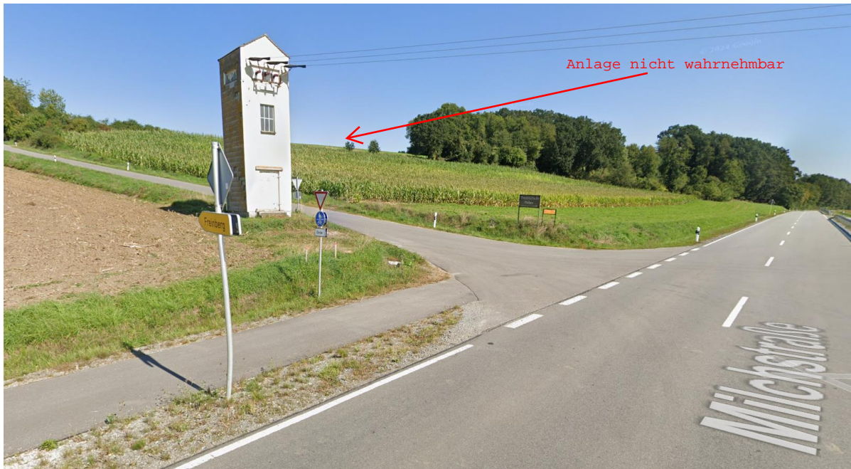
Ansicht 1: Süden von der Kreissstraße DGF 19
